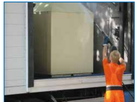
Hartnäckige Verunreinigungen werden mit Hochdruck entfernt.
