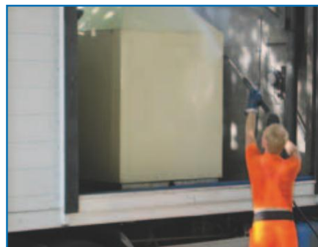
Загрязнения удаляются водой под высоким давлением.
